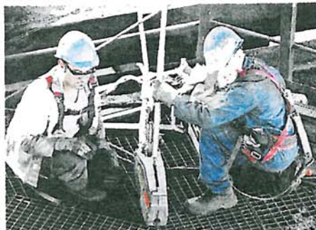
Rund 300 Arbeiter verschiedener Unternehmen demontieren derzeit das Innere von Hochofen 3.
