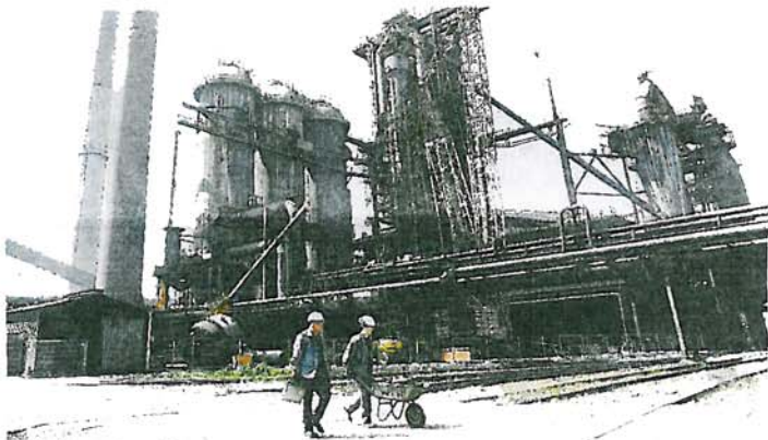
Hochofen 3 besteht fast nur noch aus dem äußeren Skelett. Unterhalb des Kranes in der Bildmitte wird zurzeit der Kern der Anlage aus Altersgründen entfernt. FOTOS: CHRISTIAN KOSAK
