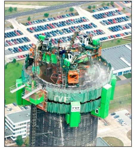
Mit einem eigens entwickelten Verfahren trägt TVF hohe Schornsteine stückweise ab
