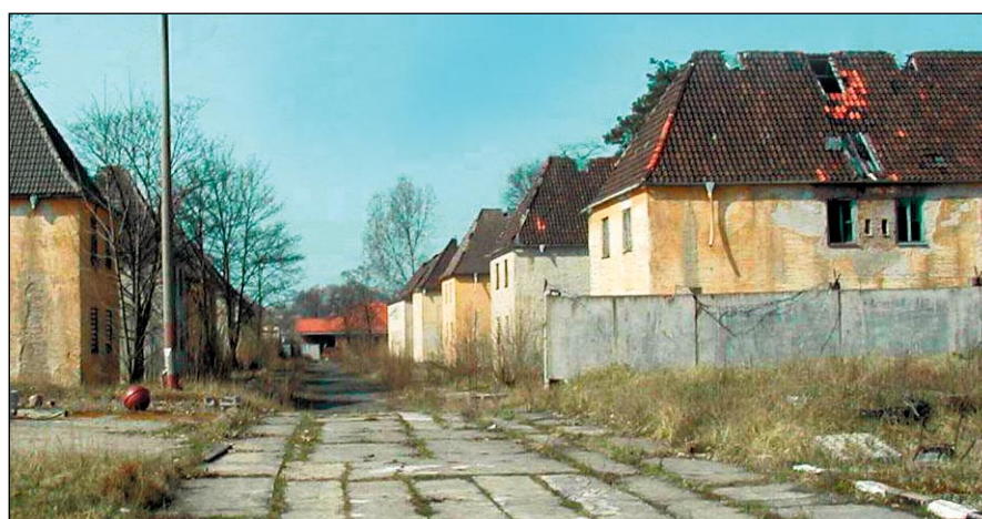
So wie in Rathenow sahen viele Kasernen in Brandenburg aus nach jahrelangem Leerstand aus ...
